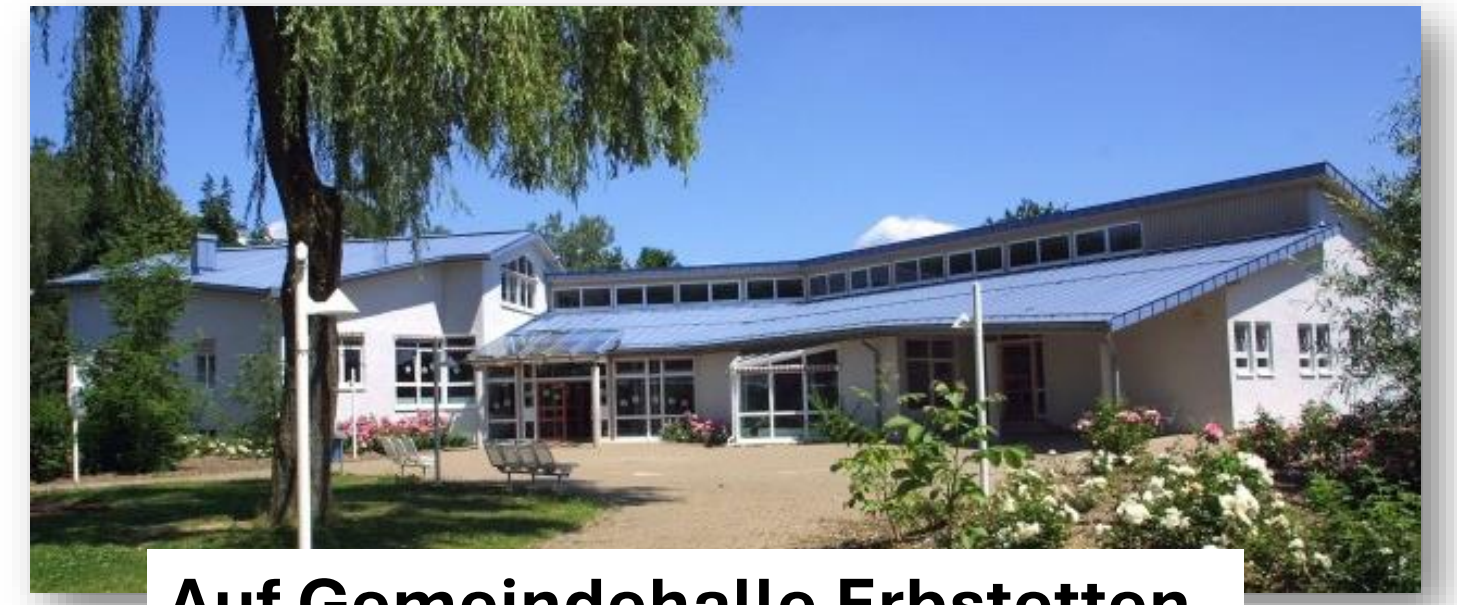
Auf Gemeindehalle Erbstetten und Grundschule Burgstall bieten Möglichkeit für Dach-PV
