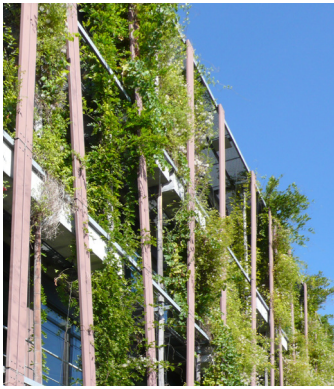
Abb. 115: oben links: Fassadenbegrünung als außenliegender Sonnenschutz des Institutsgebäudes für Physik der Humboldt-Universität in Berlin-Adlershof (Nicole Pfoser 2009)
