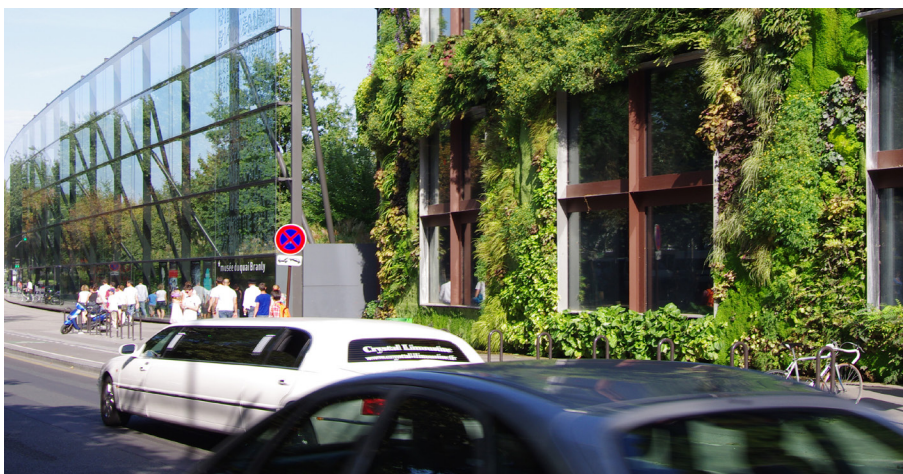
Abb. 164: Paris, Musée du Quai Branly. Kombination aus Reflektion (10m hohe Glaswand) und Absorption (flächige wandgebundene Fassadenbegrünung) des Straßenverkehr-Lärms (Foto: Nicole Pfoser 2011)
