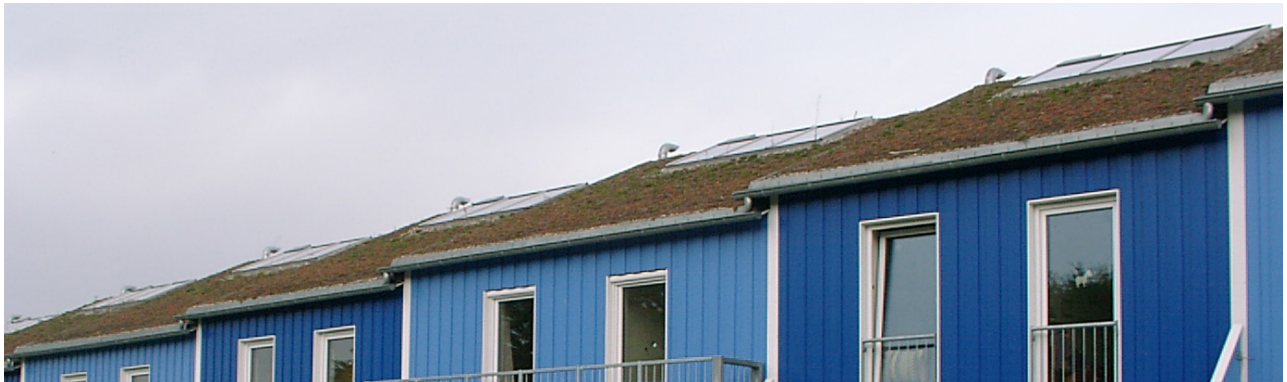
Abb. 138: Flachkollektoren in Kombination mit Gründach, Südorientierung, Passivhaussiedlung Hannover Kronsberg (Feist, W. et al.(2001))
