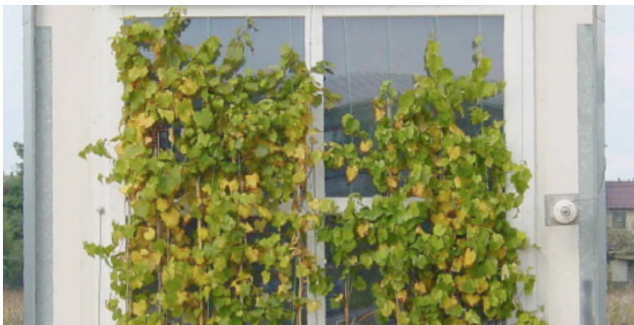
Abb. 125: Vorderansicht der TWD-Fassade mit Weinlaub am 02.10.2000. Versuchsaufbau Universität Cottbus. Fischer, U. (2002) [15]
