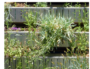
Abb. 102: unten rechts: Wandgebundene lineare Fassadenbegrünung, MA 48 (Nicole Pfoser 2012)
