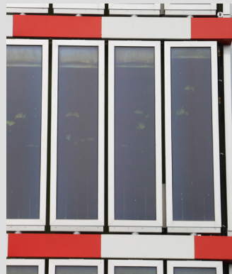
Abb. 150: links: Bioreaktorfassade mit Mikroalgenpaneelen des BIQ in Hamburg-Wilhelmsdorf (Foto: N. Jenner)
