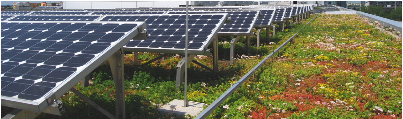
Abb. 130: PV-Aufdachanlage mit extensiver Dachbegrünung (Foto: ZinCo GmbH)
