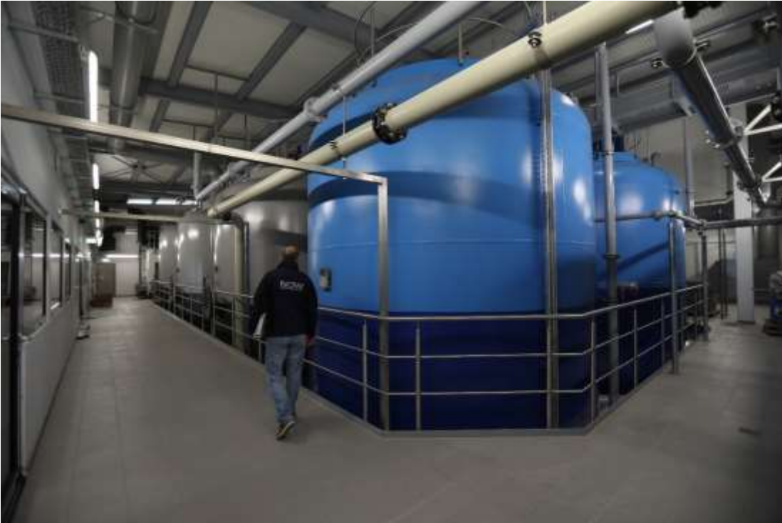
Filterhalle mit Aktivkohlefilter (grau) und CARIX-Anlage zur Wasserenthärtung (blau).
