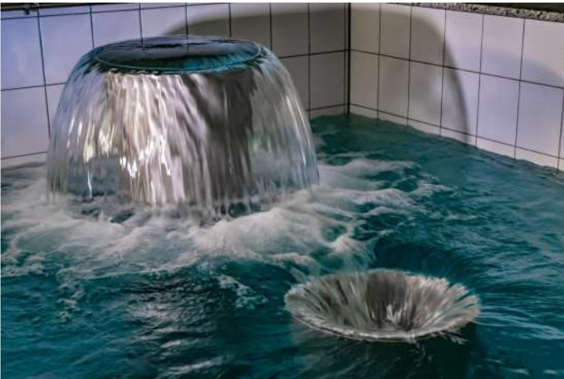
Mischkammer (Reinwasserkammer)
