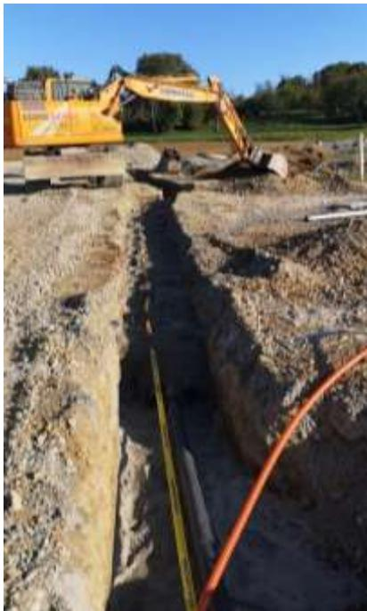
Im Baugebiet Brühl wurden die Strom- und Telekomleitungen sowie die Kabel für die Straßenbeleuchtung verlegt.
