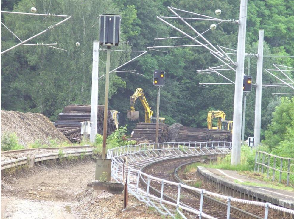
Die DB Netz AG erneuerte das komplette Gleis 1 auf einer Länge von 600m sowie beide Weichen, die auf das Gleis 1 führen.
