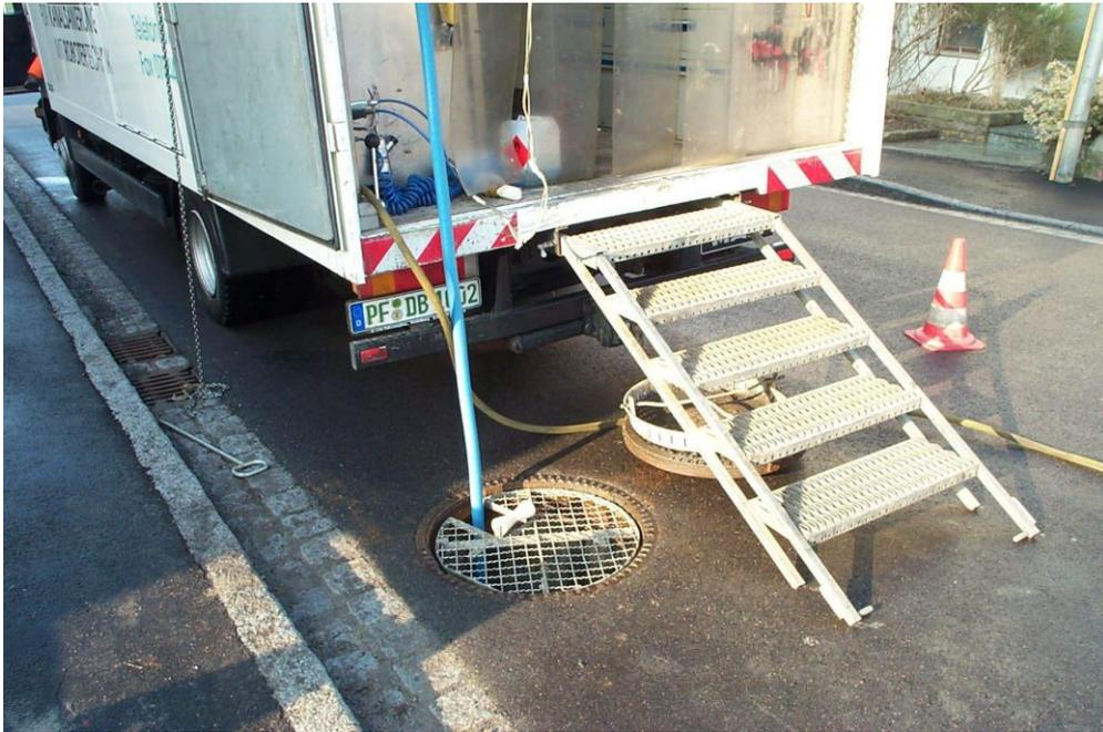
Im Frühjahr 2006 begann die Firma Boger die noch notwendigen Sanierungsarbeiten am Kanal. Beim sog. Inlinerverfahren wird ein Polyesterschlauch (Inliner) in den bestehenden Kanal eingebracht, welcher sich danach durch Wärmeeinwirkung von innen passgenau an das bestehende Rohr anlegt und aushärtet. Hierfür war es zunächst notwendig, die Ablagerungen im Kanal abzufräsen.
