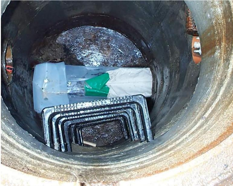
Durch das Einblasen von Warmluft legte sich der Schlauch von innen an das bestehende Rohr an und wurde anschließend mit Hilfe einer UV-Lampe ausgehärtet.
