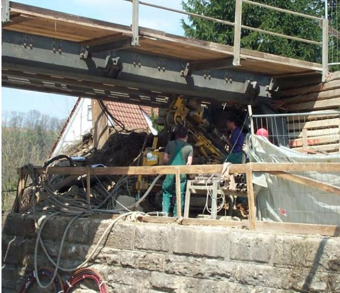
Mit Hilfe von Bohrgeräten wurden im Verlauf der Arbeiten zunächst im oberen Wandabschnitt Rückverankerungen eingebohrt, die den Verbau halten und damit die Baustelle sichern sollten. Mit dem Abtrag der alten Widerlager rückten diese Bohrgeräte nach unten bis zur Sohle des Bahndurchlasses vor, wo jeweils weitere Rückverankerungen gesetzt wurden.
