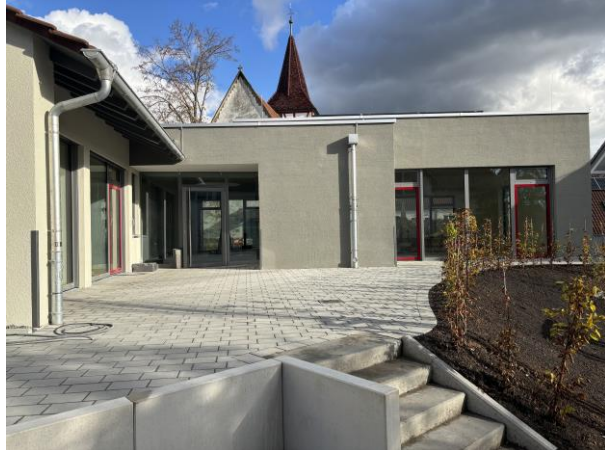
Neuer Eingangsbereich im hinteren Teil des Gebäudes
