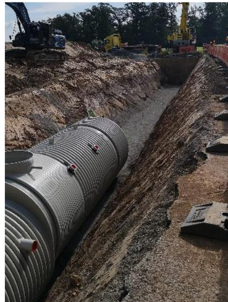
Nachdem die einzelnen Teile des insgesamt 40 Meter langen Behälters angeliefert waren, wurden diese zusammenschweißt und in die Baugrube gesetzt. Anschließend wurde der Löschwasserbehälter „Auf den Rüdern“ eingebaut.
