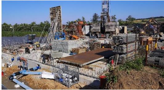
Für die Erstellung der Außenwände wurden die Schalungen errichtet.
