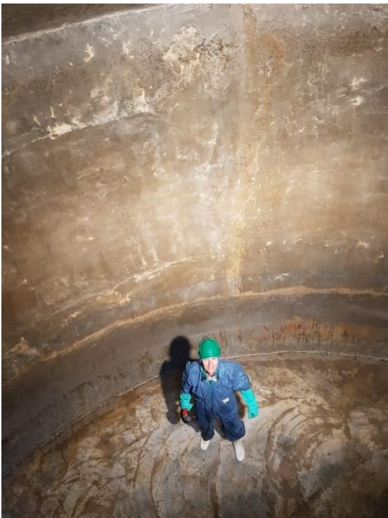
Wassermeister im Hochbehälter
